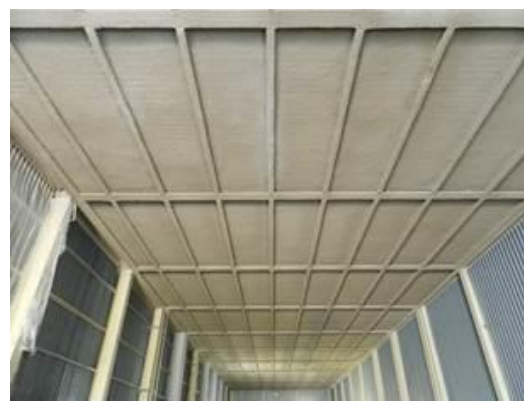
Figura 2-63 – Attività di posa dell'intonaco ignifugo
