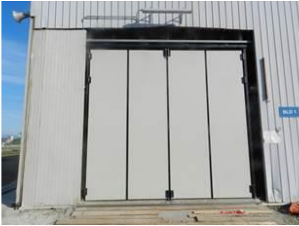
Figura 2-87 – Attività di montaggio portone accesso materiali
