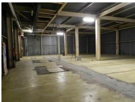
Figura 2-33 – Rimozione del linoleum nel locale A221
