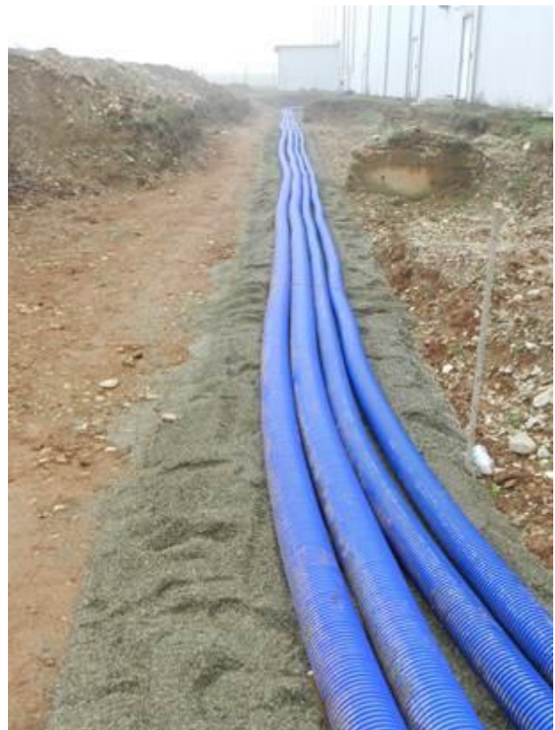
Figura 2-76 – Montaggio tubazioni interrate per fluidi termovettori
