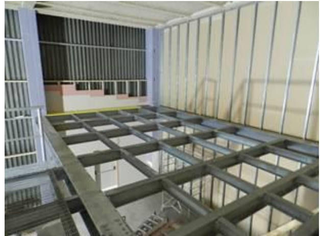
Figura 2-73 – Montaggio pareti laterali del soppalco
