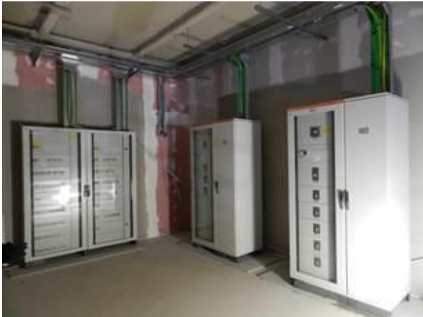
Figura 2-83 – Installazione Quadri elettrici e UPS
