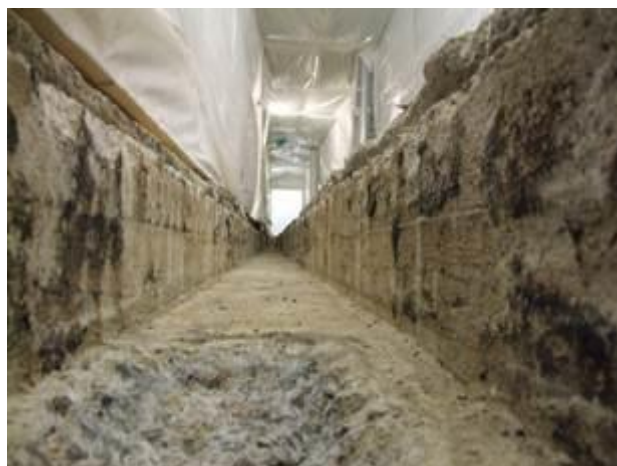
Figura 2-52 – Scarifica cunicolo corridoio A214
