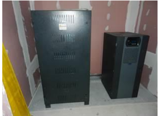
Figura 2-83 – Installazione Quadri elettrici e UPS
