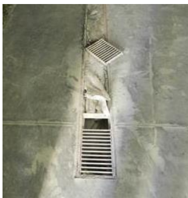
Figura 2-59 – Attività di montaggio delle canaline del sistema drenaggi all'interno del B106
