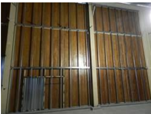
Figura 2-69 – Attività di rivestimento in cartongesso pareti Area di Stoccaggio
