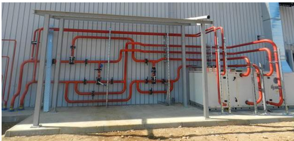
Figura 2-80 – Montaggio tubazioni per fluidi termovettori
