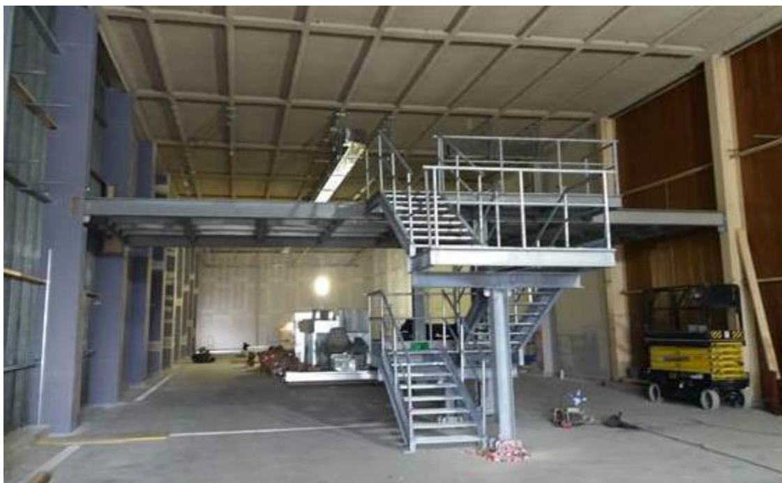
Figura 2-72 – Montaggio struttura metallica del soppalco
