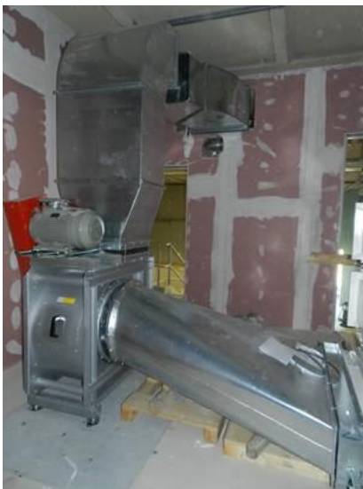
Figura 2-84 – Installazione ventilatore di estrazione e canister
