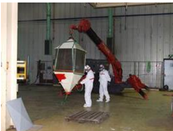
Figura 2-16 – Smontaggio filtri elettrostatici nell'area A124
