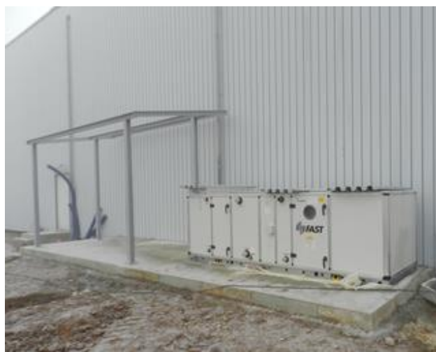
Figura 2-78 – Installazione UTA esterna su basamento in calcestruzzo
