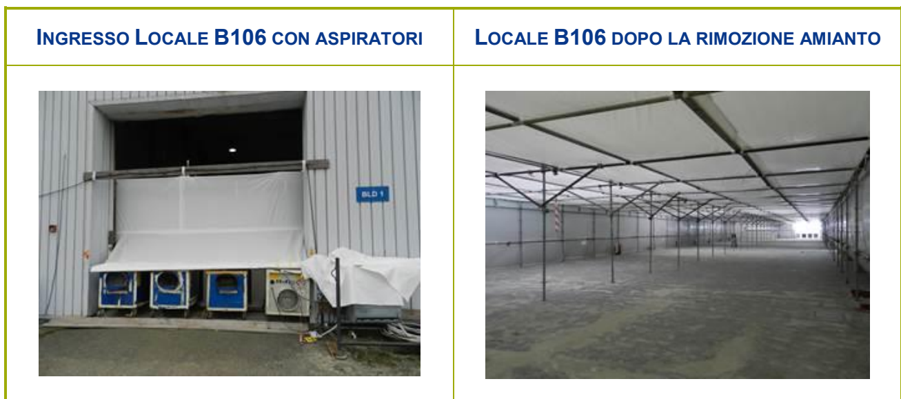
Figura 2-55 – Attività di rimozione amianto dalla pavimentazione del locale B106
