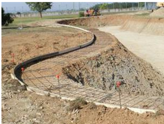
Figura 2-107 – Attività di realizzazione del bacino idrico
