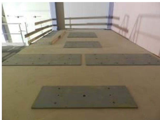
Figura 2-74 – Attività di montaggio della pavimentazione del soppalco
