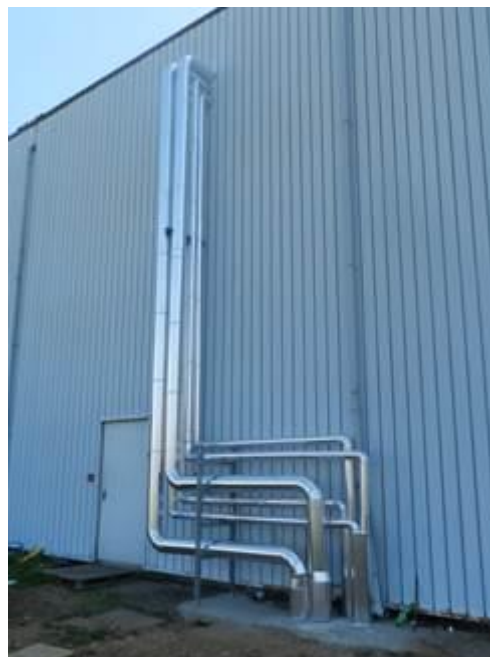
Figura 2-81 – Attività di coibentazione delle tubazioni dei fluidi termovettori
