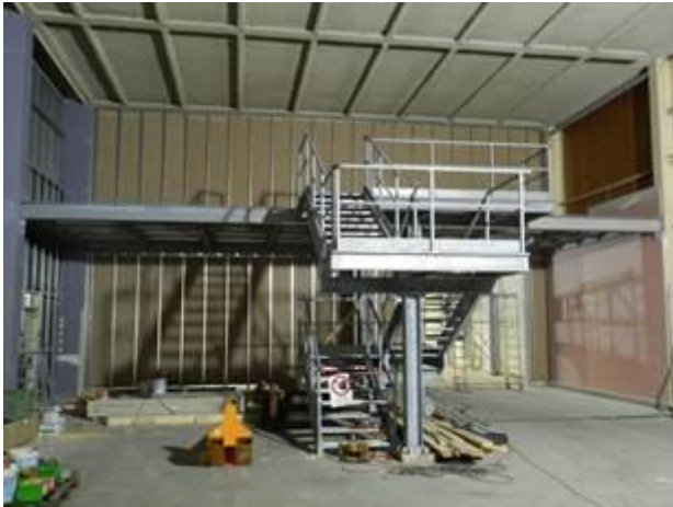
Figura 2-73 – Montaggio pareti laterali del soppalco
